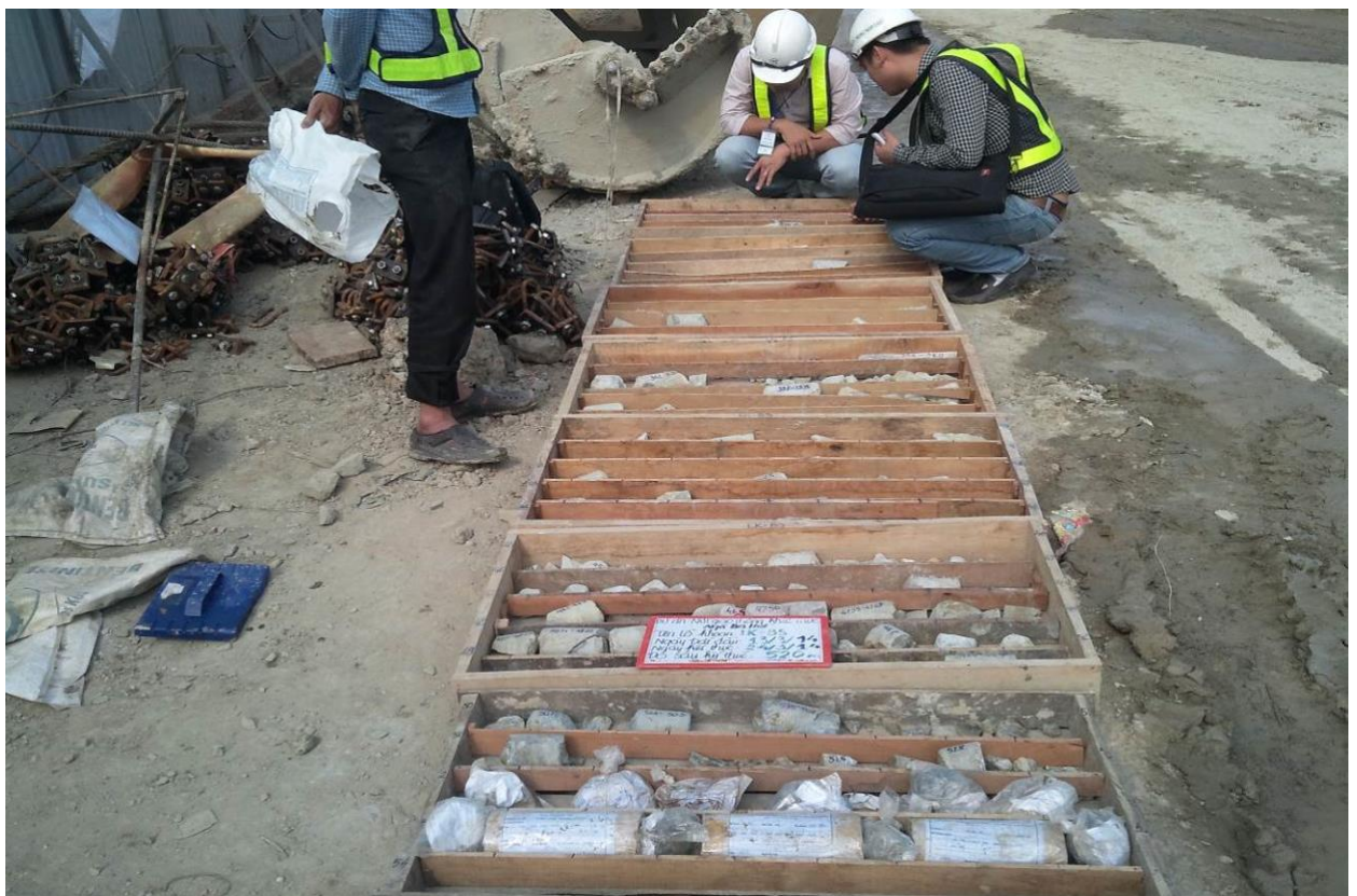
Khoan địa chất công trình
